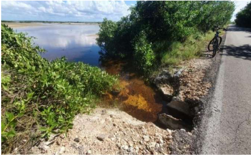
Figura 18. Canal en la carretera San Crisanto-Sinanché, que conecta la ciénega con las charcas salineras. (Foto: M. Casares).
