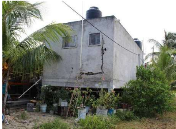
Figura 14. Palafito ubicado sobre la carretera principal de San Crisanto, entre Telchac y Chabihau. (Foto: M. Casares).
