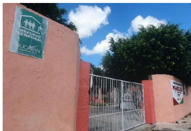
Figura 12. Escuela primaria Miguel Hidalgo y Costilla, Sinanché. (Foto: M. Casares).
